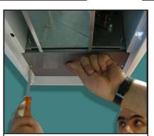
Remonter les 2 obturateurs à l'aide de 4 vis ( 2 vis par obturateur ).
